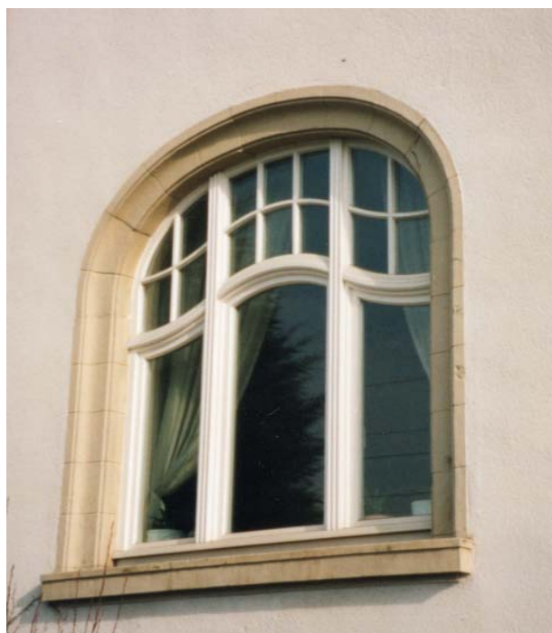
Gelungene Fenstererneuerung in einem historischen Gebäude
