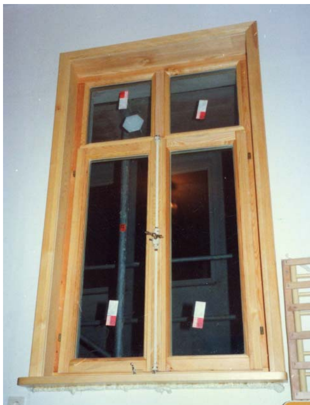
Neues Fenster mit originalgetreuem Holzrahmen und Wärmeschutz-Isolierverglasung (Die Beschläge wurden wieder verwendet)
