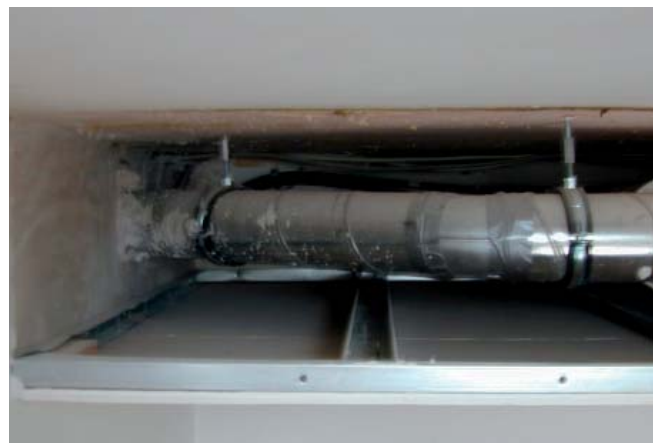
Ein Blick von der Seite: Ein Lüftungsrohr in einer abgehängten Decke
