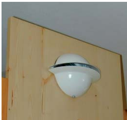
Zuluftventil in Form einer „Weitwurfdüse“; hier eingebaut in ein Regal.
