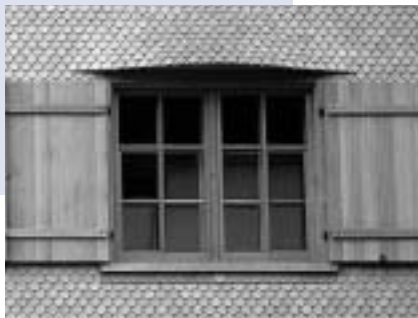
Bei diesem Fachwerkhaus ist die Wetterseite als Regenschutz mit Holzschindeln verkleidet, um die Lebensdauer des Fachwerks zu verlängern.
