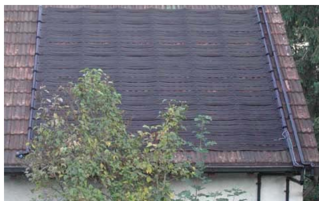
Dachfläche mit Absorbermatten
