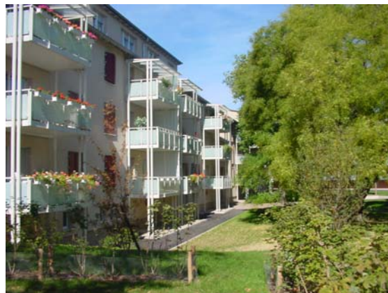
Abb. 2.7: Südansicht 3-Liter-Haus: Die Balkone stehen thermisch getrennt vor der Gebäudehülle, die Fensterläden erfüllen keine energetischen Anforderungen
