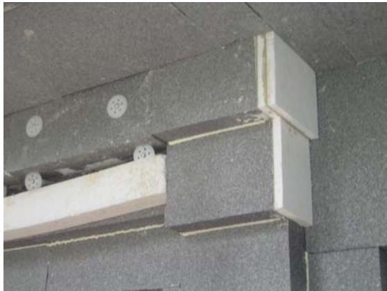
Konsequente Dämmung schwieriger Elemente
