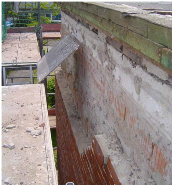
Abbruch einer Klinkerfassade als Vorbereitung für eine nachträgliche Wanddämmung
