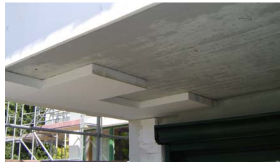
Wärmebrückenvermeidung: Dämmung einer Balkonplatte
