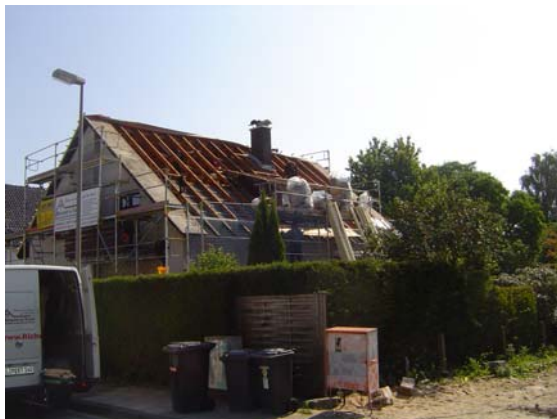
Während der Sanierung
