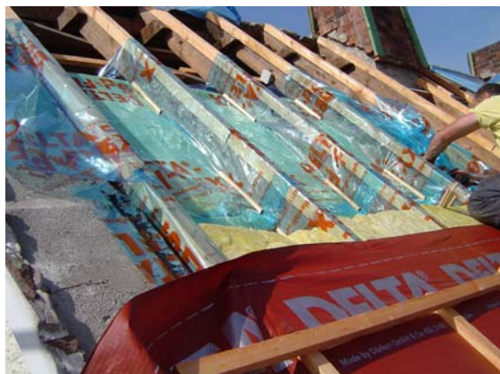
Wichtige Luftdichtung bei der Dachsanierung
