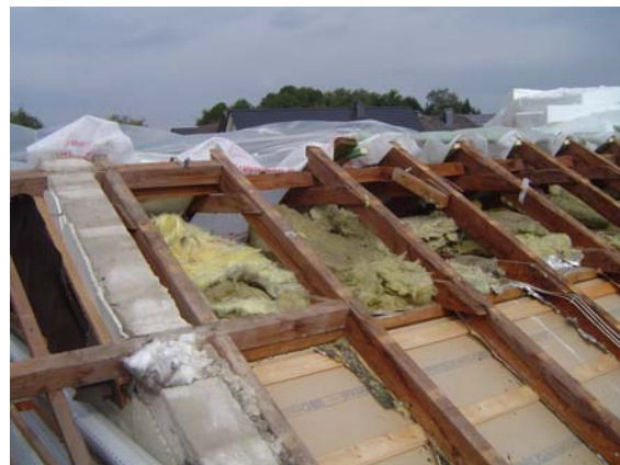
Dach während der Sanierung.
