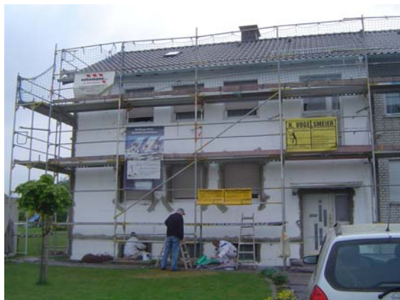
Sanierung eines Zweifamilienwohnhauses
