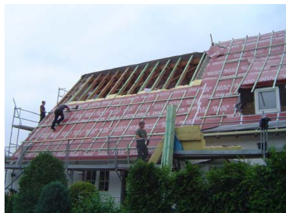
Dachsanierung eines Zweifamilienwohnhauses nach herkömmlicher Art mit Sparrenaufdoppelung
