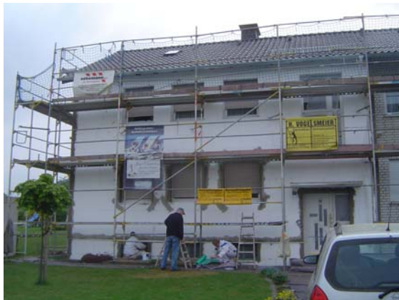
Sanierung eines Zweifamilienwohnhauses
