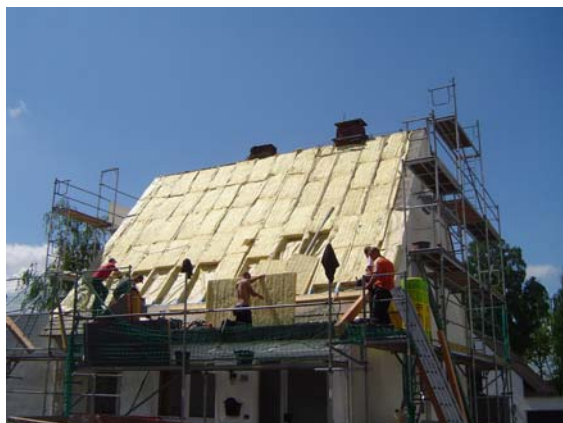
Dachsanierung eines Einfamilienwohnhauses. Zu erkennen ist Luftdichtungsebene mit Zwischensparrendämmung. Es folgt noch eine Aufsparrendämmung
