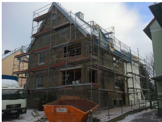
Gesamtsanierung eines alten Siedlungshauses
