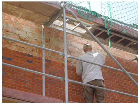
Entfernung der Verklinkerung vor Montage der neuen Außendämmung
