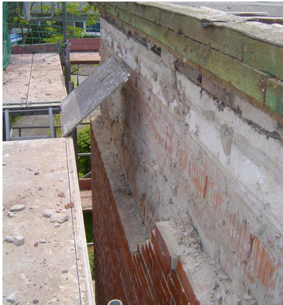
Abbruch einer Klinkerfassade als Vorbereitung für eine nachträgliche Wanddämmung
