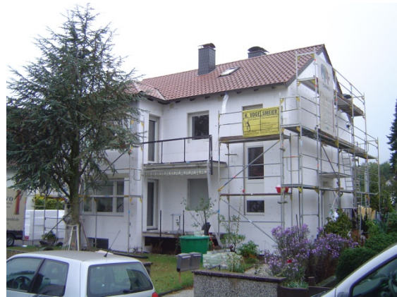
Gesamtsanierung eines Zweifamilienhauses.
