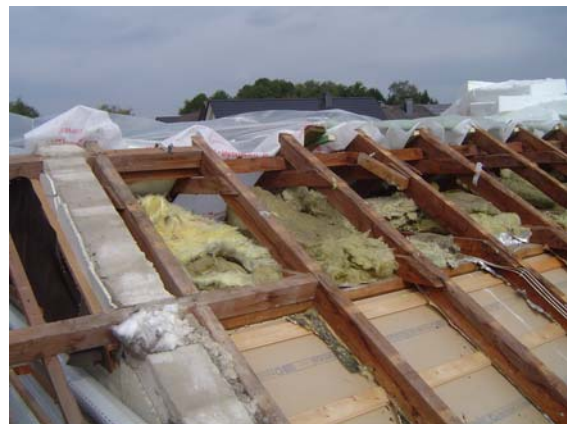
Dach während der Sanierung.
