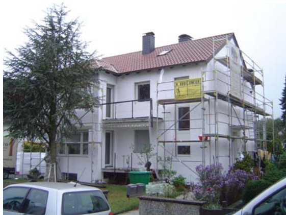
Gesamtsanierung eines Zweifamilienhauses
