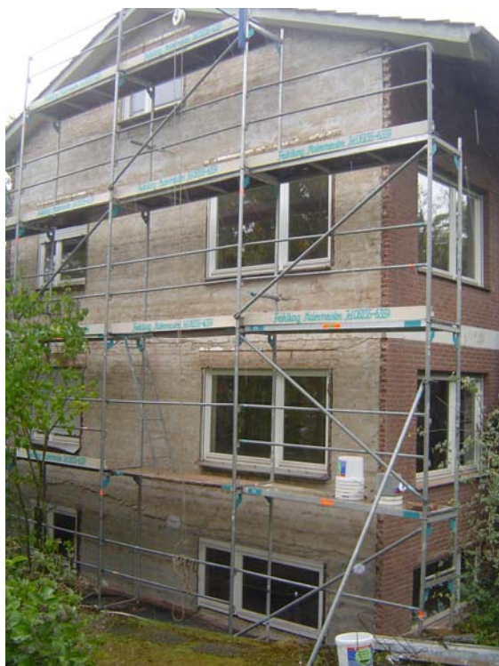
Abriss einer Klinkerfassade vor Montage einer neuen Dämmung.
