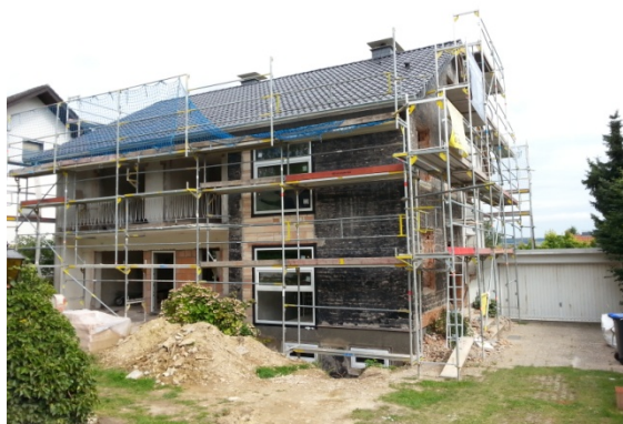
Gesamtsanierung eines Wohngebäudes.
